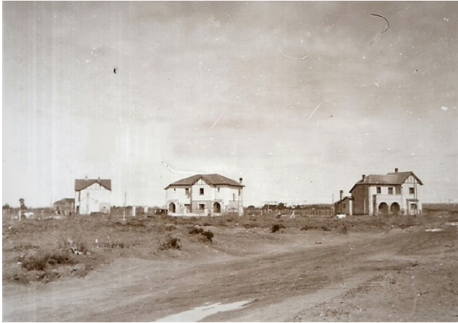
Imagen 7. construcción del barrio Fitte
