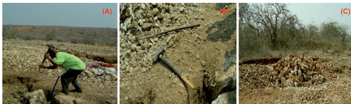
FIGURA 6. Explotación artesanal de calizas en Pomba. A. Obrero en labor de fracturación de las rocas. B. Instrumentos rudimentarios utilizados. C. Acopio del material en montículos.
