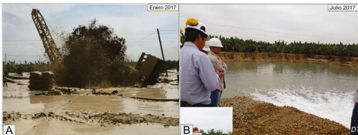
**Figura 3.** Fotografías que documentan la situación generada por el pozo Alejandrina. **A.** Momento del reventón que provocó el colapso del equipo de perforación. **B.** Cráter generado por la subsidencia e inundación del sitio de emplazamiento.
