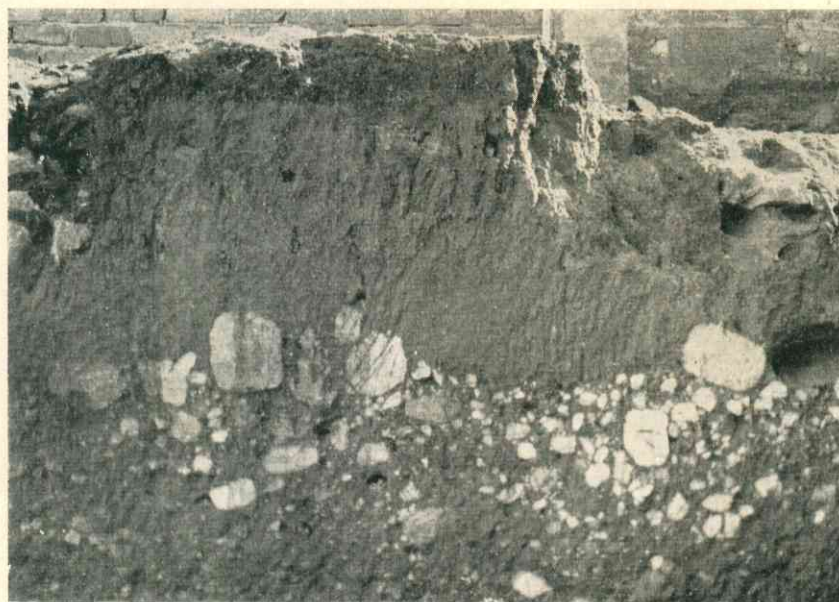
Lámina III. Foto 2. — Limos rojos de la terraza de Bucaramanga (1,5 m de espesor) apoyándose sobre los cantos de la parte más alta de la terraza. Excavación para los cimientos de una casa en la Carrera 15, entre calles 36 y 37, Bucaramanga.
