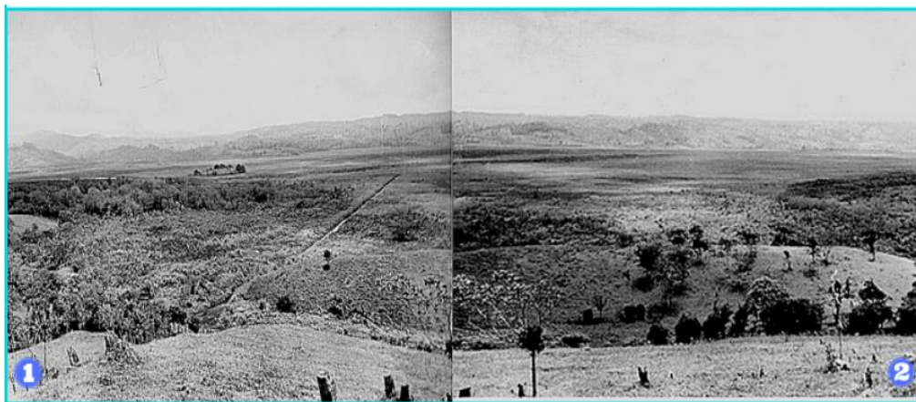
Figura 2. Vista panorámica del Valle de Arenal antes del llenado del embalse
