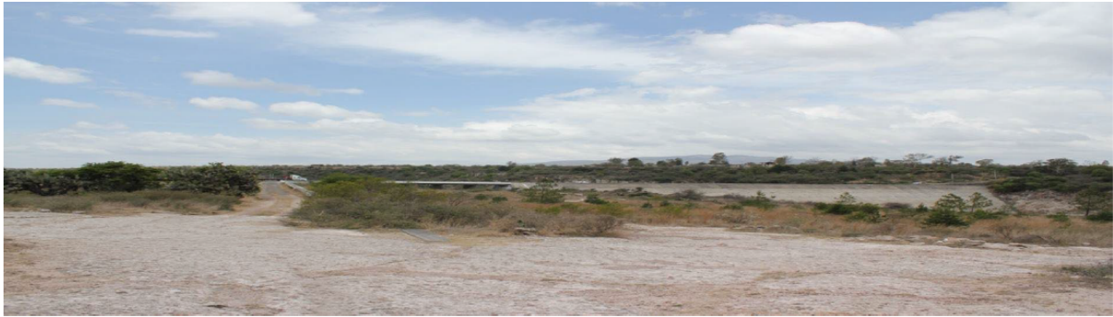
Figura 9. Presa Madero. Panorámica actual. Fuente: Fotografía de la presa Madero.
