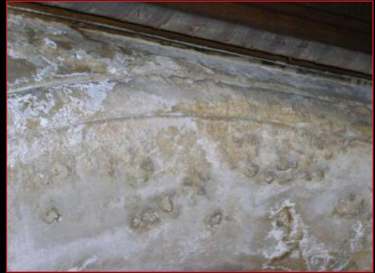
Salitre resultante del ascenso capilar de agua y de una tasa elevada de humedad
