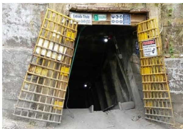
Figura 4. Proceso de excavación: entrada al túnel con estructura interna de madera. Fuente: Elaboración propia.
