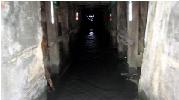
Figura 8. Proceso de desvío de aguas subterráneas. Canal interno de desagüe de aguas subterráneas. Fuente: Elaboración propia.
