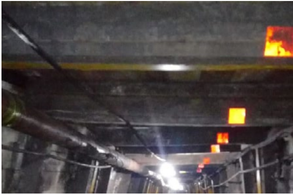
Figura 7. Proceso de avance del túnel: red eléctrica para la iluminación de la mina. Fuente: Elaboración propia.
