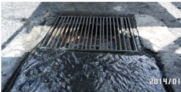
Figura 9. Proceso de desvío de aguas subterráneas: llegada de las aguas subterráneas a la entrada de la mina. Fuente: Elaboración propia.
