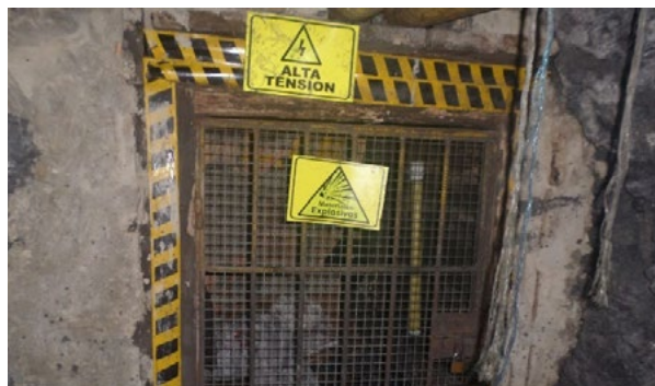
Figura 5. Proceso de excavación: zona de almacenamiento de explosivos. Fuente: Elaboración propia.
