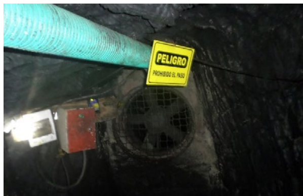
Figura 6. Proceso de avance del túnel: sistema de ventilación con ventiladores internos. Fuente: Elaboración propia.
