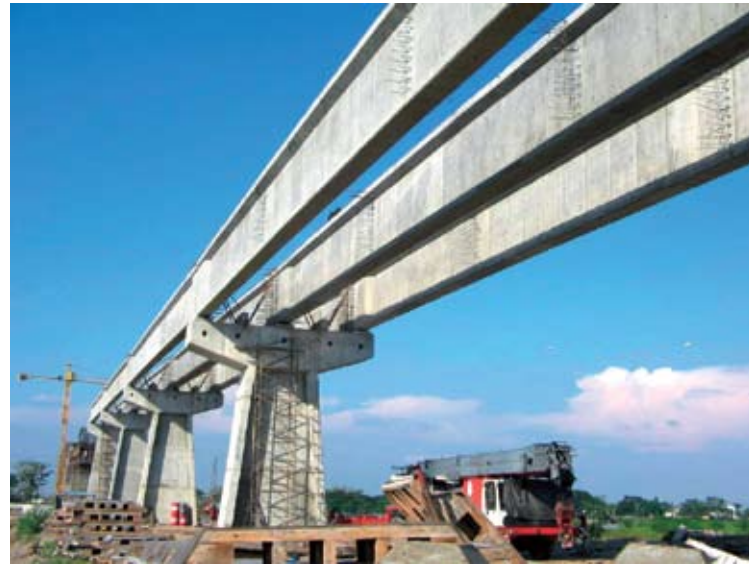
Vista completa del montaje de vigas en el sector de plataforma entre los apoyos 8 y 12.
