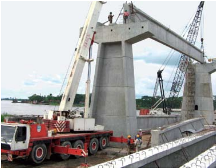
Montaje de vigas en el sector de la plataforma entre apoyos 8 y 12.
