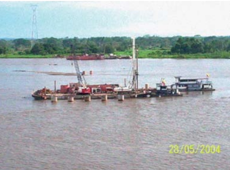
Panorámica de los trabajos de pilotaje en el río.
