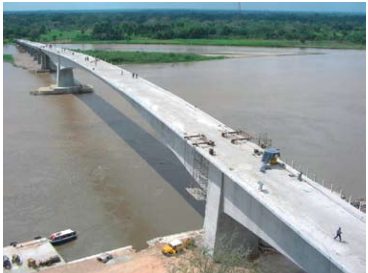
Panorámica parcial del puente desde el costado de Barrancabermeja.
