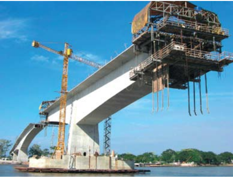
Primer plano del apoyo 7 del puente principal.
