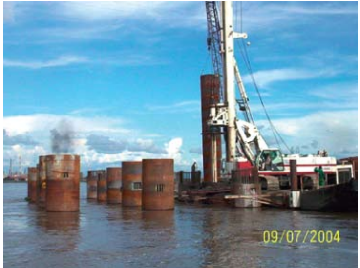
Hinca de camisas para la construcción de pilotes en el agua. (Apoyo 7)
