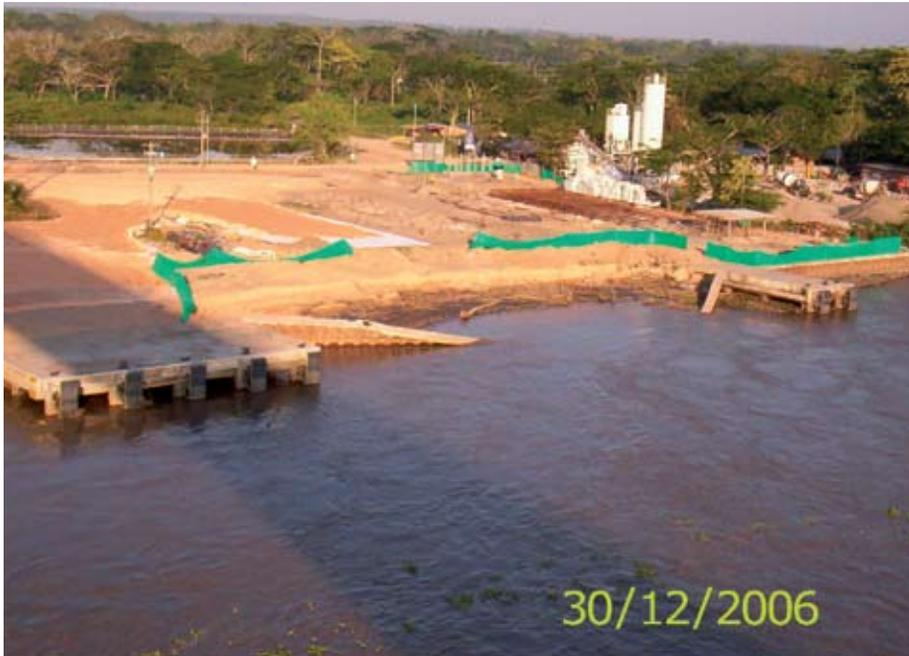
Diciembre 2006. La socavación en la orilla derecha produce el colapso de las tabletas del puerto multimodal (Foto Laura Ayala).
