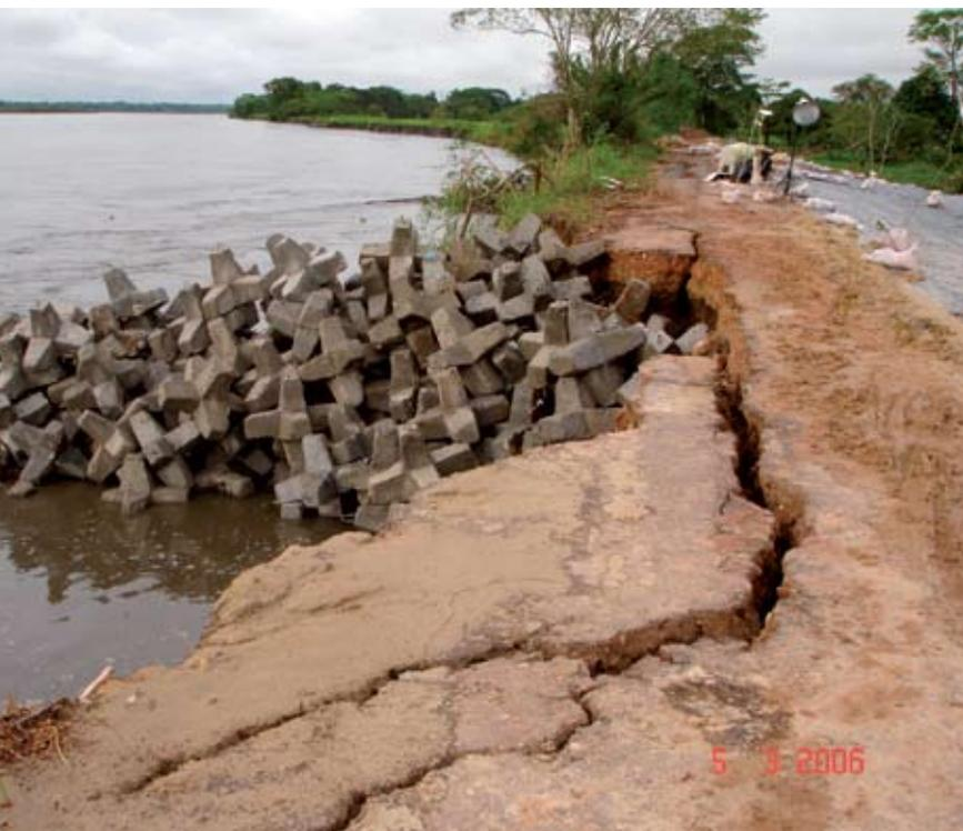
El puerto de Galán está sufriendo actualmente un proceso de socavación acelerada que está en relación directa con la presencia del puente. El primer efecto fue la falla del tablestacado, y se pueden esperar mayores problemas en el futuro.
