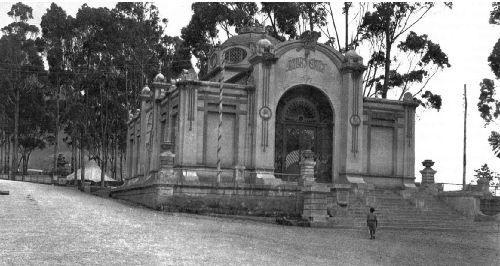
Pabellón de las Bellas Artes.
