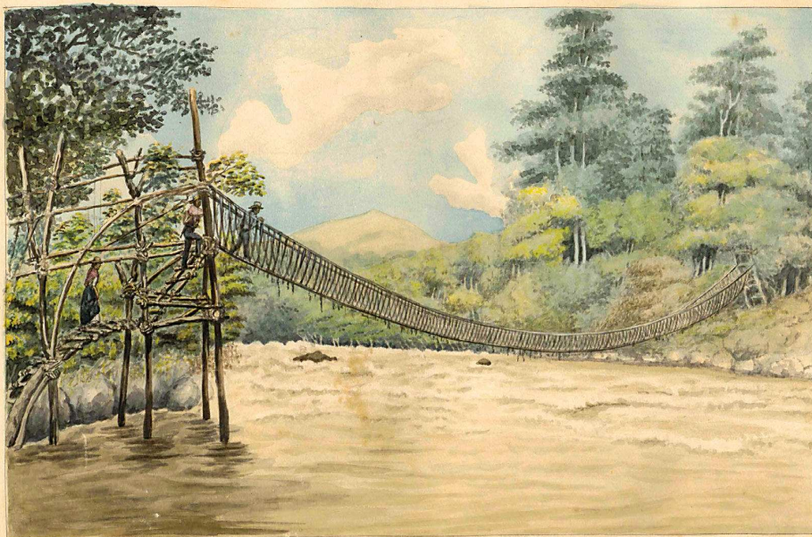
Puente colgante de boques sobre el Luján provincia de Santander
