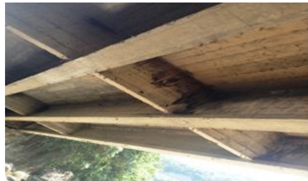
Figura 2. Tipología viga-losa, vista inferior La Parroquia. Fuente: autores
