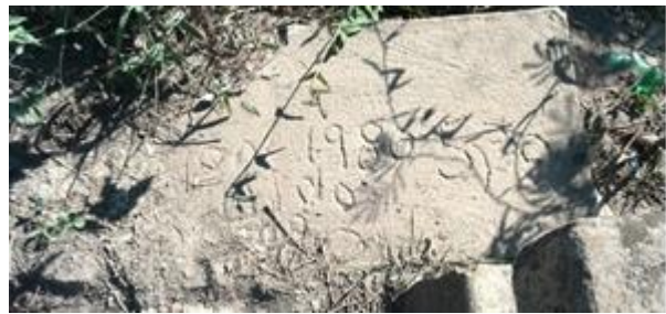
Figura 5 . Escritura de año de construcción del puente. Fuente: autores
