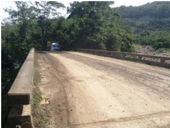
Figura 7. Vista superior del tablero. Fuente: autores.
