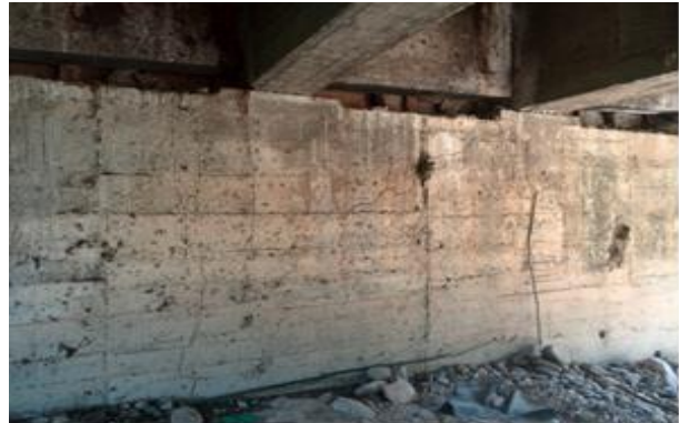
Figura 4 . Estado actual de estribos y apoyos
