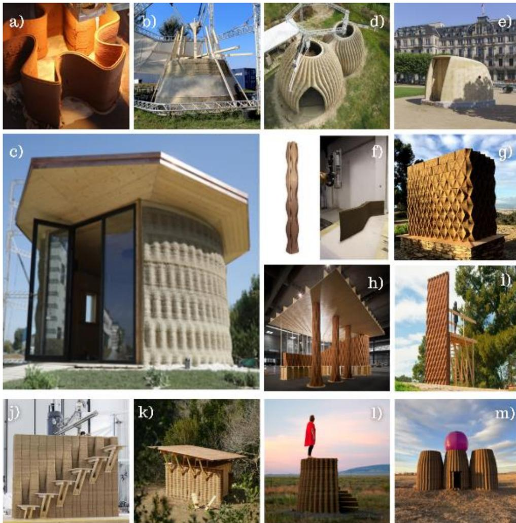
Figura 11. Prototipos impresos en 3D con materiales basados en suelos. (a) Primera estructura impresa en Arcilla de Ait Ben Haddou [71]; (b) EREMO primer intento de casa impresa en 3D [72]; (c) GAIA primera casa impresa en 3D [73]; (d) Proyecto TECLA [74]; (e) The house of dust [75]; (f) Proyecto Pylos [76]; (g) TerraPerforma [77]; (h) Pabellón [78]; (i) Digital Adobe [79]; (j) Muro con escalera [80]; (k) TOVA [81]; (l) Mud Frontiers [82]; (m) Casa Covida [83].
