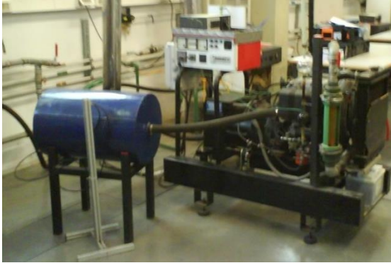
Figura 6. Detalle del grupo electrógeno instrumentado para las pruebas. Fuente. Elaboración propia.
