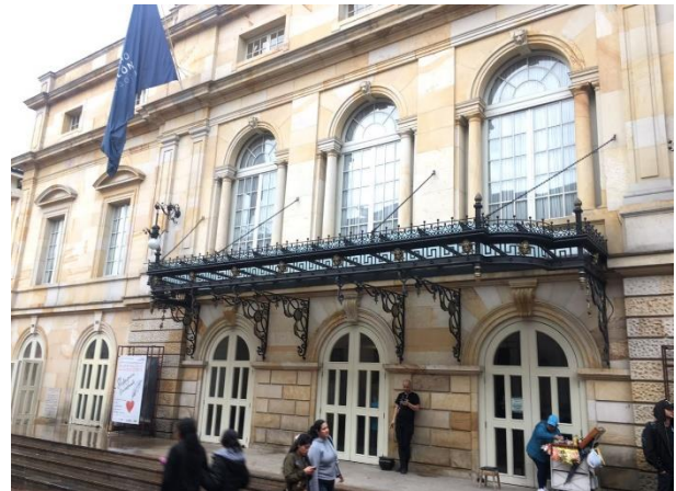
Figura 2. Utilización de piedra muñeca en la remodelación del Teatro Colón en Bogotá. Fuente: elaboración propia.
