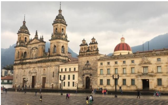
Figura 1. Utilización de piedra muñeca en construcciones patrimoniales de la Ciudad de Bogotá, Catedral Primada de Colombia, Capilla del Sagrario y Arquidiócesis de Bogotá. Fuente: elaboración propia.
