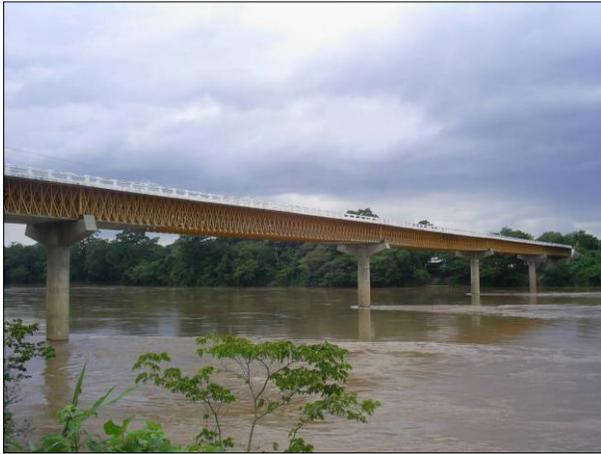
Figura 1. Puente Boca Lacantún, de tridilosa continua
